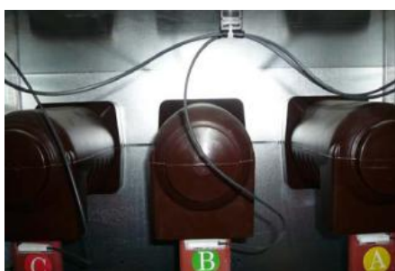
传感器固定及绝缘光缆走线
