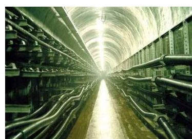
各类感温光缆铺设示意图
