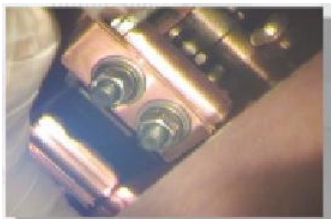
检查无励磁分接开关各部件是否存在过热或接触松弛现象
